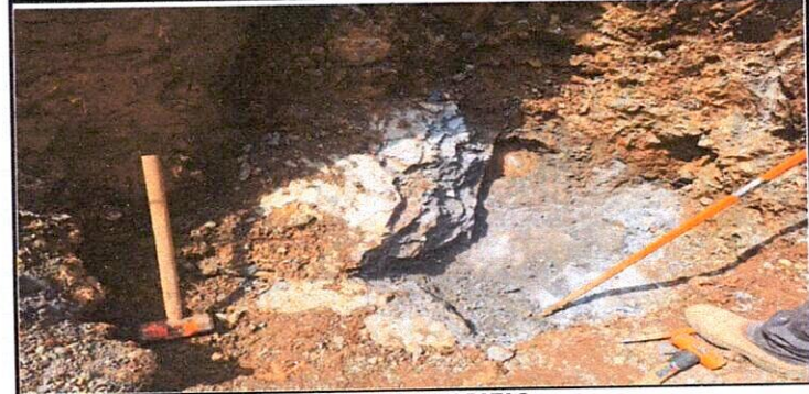
Foto 4: PROCESO DE COLOCACIÓN DE ZAPATAS.
