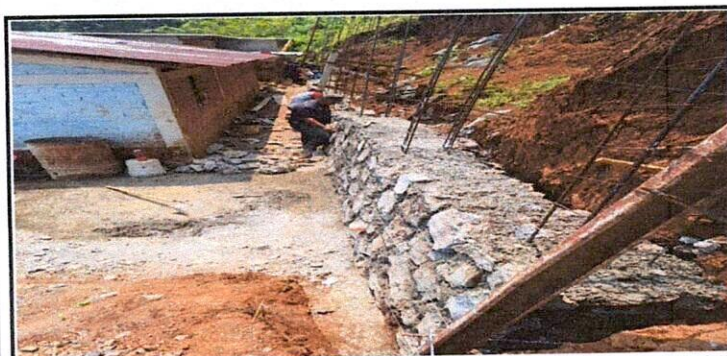
Foto 5: AVANCES EN PROCESO DE MURO DE CONTENCIÓN
