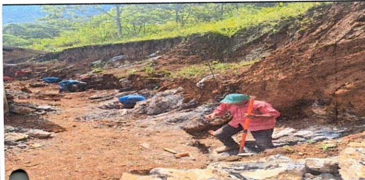
Foto 3: PERFORACIÓN DE 1.5 METROS DE PROFUNDIDAD PARA CIMIENTOS.
